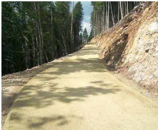
Il sentiero che verrà trasformato in ciclabile e, a destra, un esempio di massetto drenante per pavimentazioni
